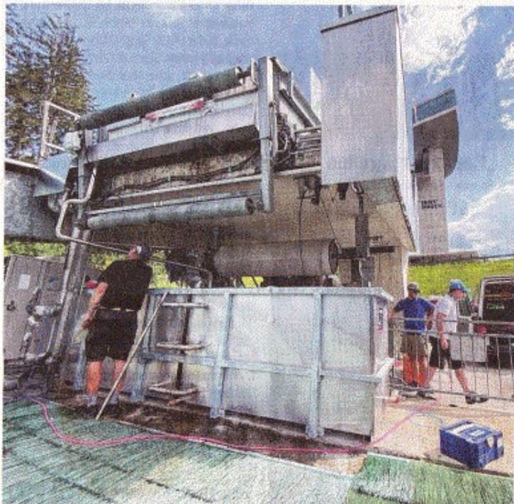
Unterm Schanzentisch der Bergisel-Schanze stehen seit dieser Woche zwei miteinander verbundene Wassertanks des Kreislaufsystems. FOTO: PETER RIEDEL
